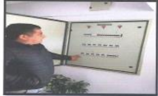
Capacitación en manejo tablero eléctrico.
